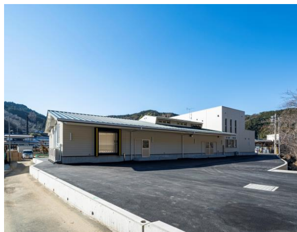
2023年1月竣工 (有)クマミ手作り和惣菜工場新築工 事
